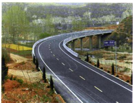
洛栾路叫李庄2号大桥
