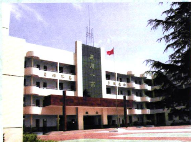
综合教学楼。建筑面积5680平方米，除设计有24个标准教室外，还有各学科教师办公室、图书室、阅览室和可容纳千余名学生听讲的多媒体报告厅。
