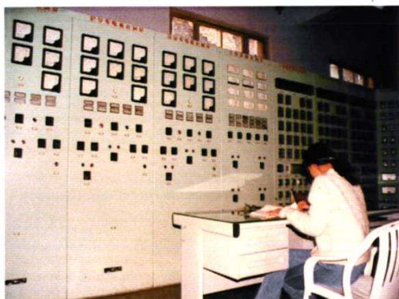
月亮湾水电站工作区
