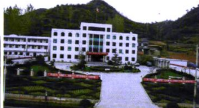
庙子乡人民政府办公大楼
