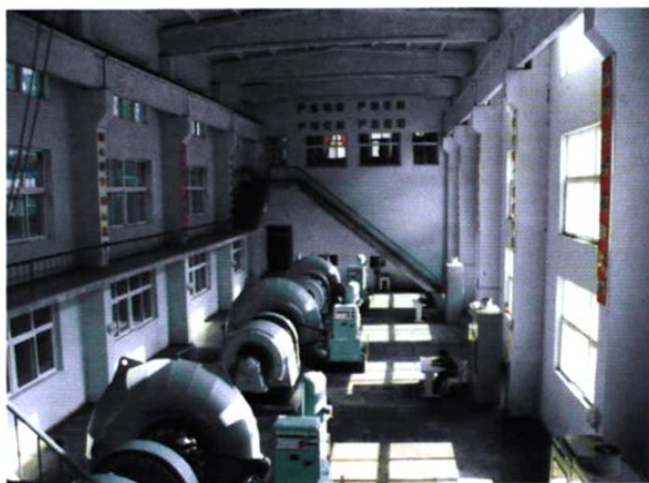
马路湾电站厂房
