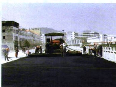
君山路改建工程铺油工地
