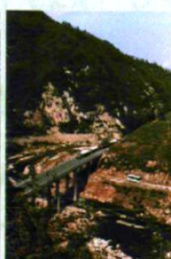
2003年9月建成的311国道红洛河大桥
