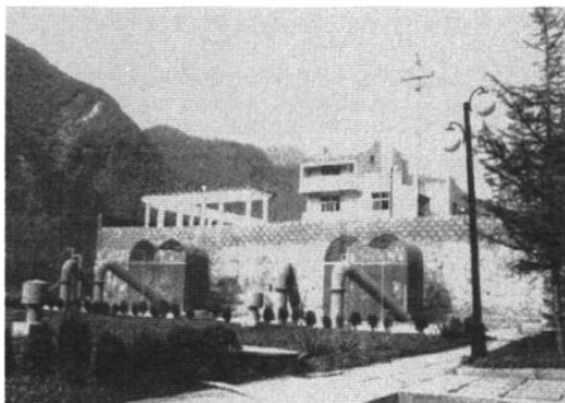
1997 年 9 月建成投入使用日供水 1.5 万吨的九鼎沟水厂。
