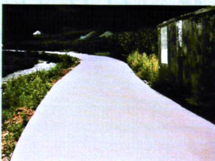
新建成的行政村公路
